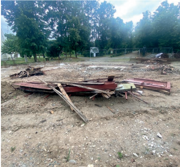
Porta de la intrarea în Parcul Sportiv Iuliu Hațieganu, transformată într-un morman de scânduri rupte
